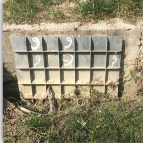
Esempio di valvola a battente (clapet) su scarico fognario Valvola a battente (clapet) su tratto arginale (Asti)
