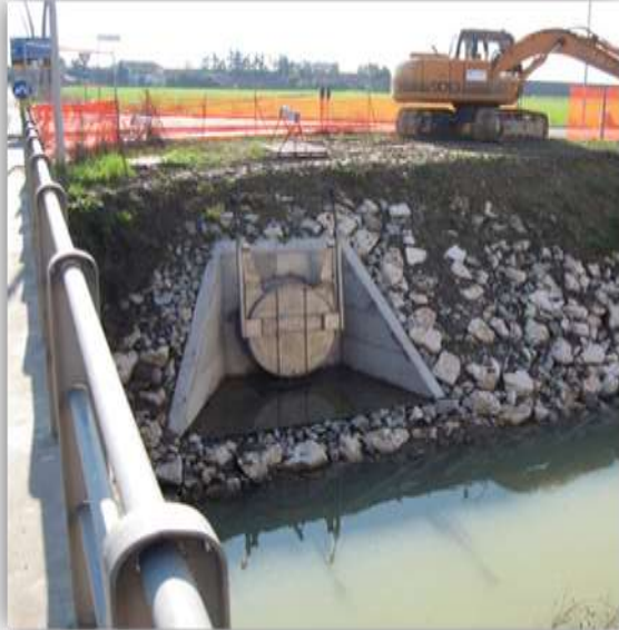
Esempio di valvola a battente (clapet) su scarico fognario Valvola a battente (clapet) su tratto arginale (Asti)
