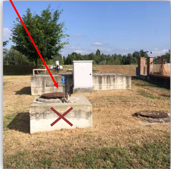
Vista manufatto con spalle Strada Trincere
