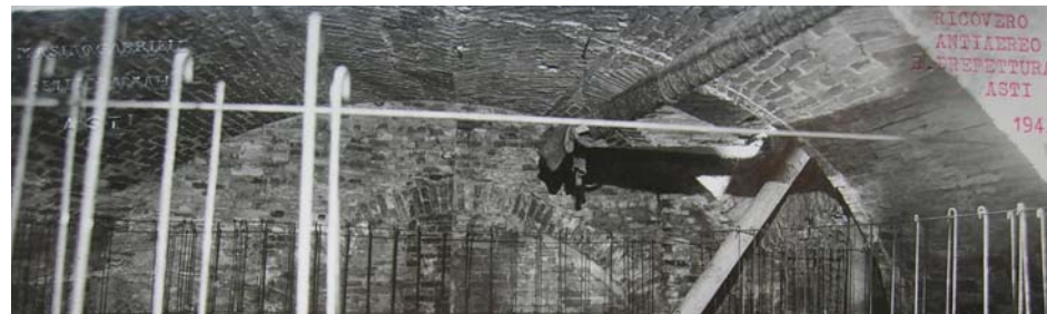
Asti, Il rifugio antiaereo in Palazzo Ottolenghi - 1943. Vista delle armature per soffitto in cemento armato.
